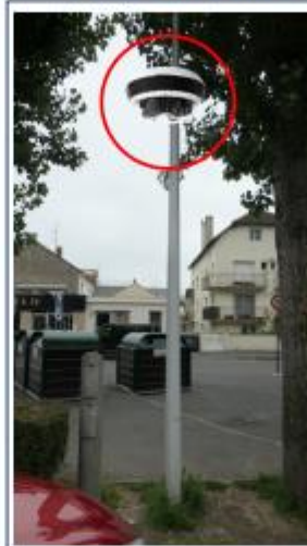
Fixation sur candélabre N° 20-12 (Relai Radio sur 26-17)
